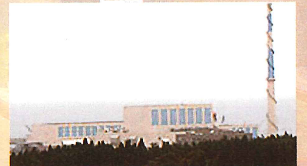
東通原子力発電所（提供：東北電力株式会社）
