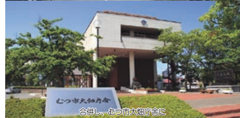
開通した国道279号大畑バイパス
