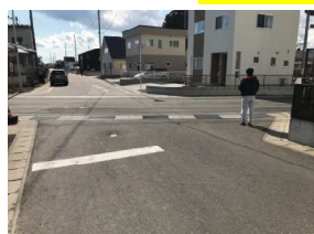
角地での隅切り工事
