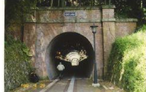
北吸トンネル（旧鉄道隧道）
