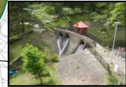
国の重要文化財 沈澄地堰堤
