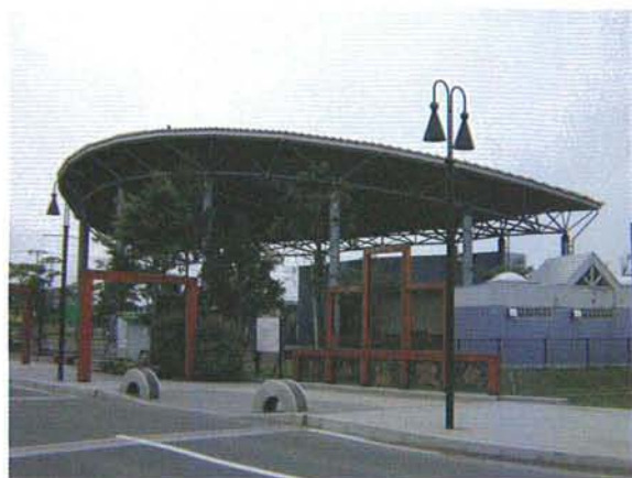
きれいに整備された来さまい橋通りとイベント広場。
