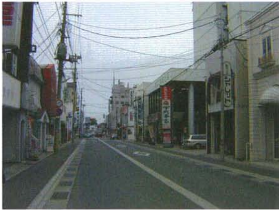
国道 279 号沿道の本町商店街。歩車道の段差はうまく処理されているが、歩道が狭く、電柱が歩行の妨げとなっている。緑が少なく、潤いにかける印象がある。沿道にはホテルも多い。
