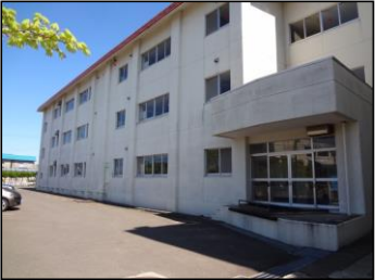
大畑小学校北棟(現況)
