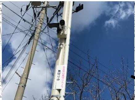
①：市道小川町連絡一号線側を撮影
