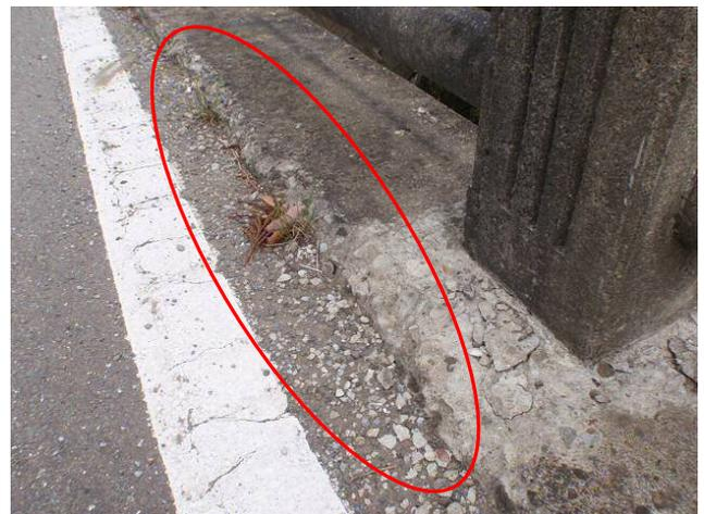
図3-9 地覆に発生した凍害による損傷事例【2】
