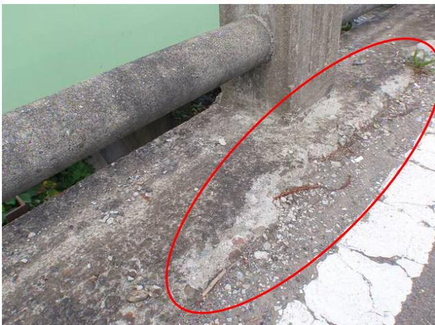
図3-8 地覆に発生した凍害による損傷事例【1】
