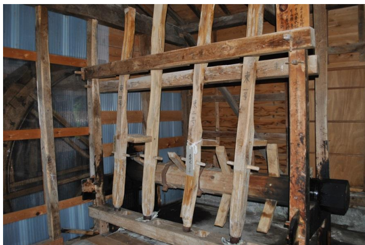
▲ 宿野部水車小屋内 水車軸につけられた杵
