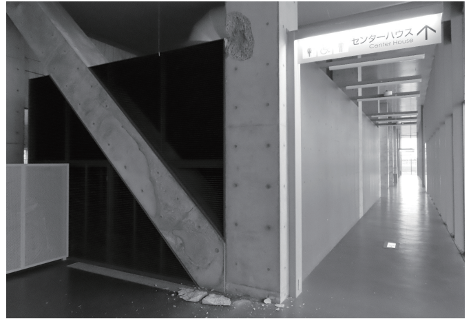
地震によりしもきた克雪ドーム内の柱の一部が破損
