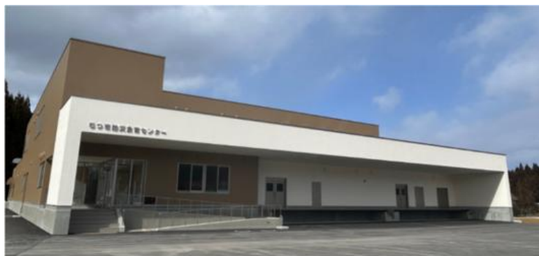
防衛施設周辺民生安定施設整備事業補助金を活用して建設したむつ市防災食育センター
