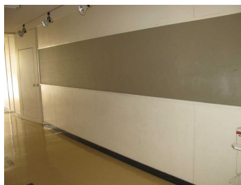
コア 2-2 外観 (廊下)
