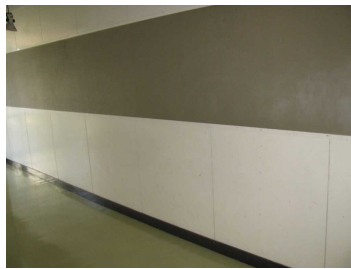
コア 1-2 外観 (廊下)
