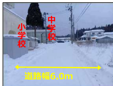
敷地内道路幅6m
