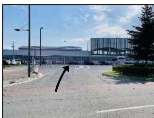
北口ロータリー入口
