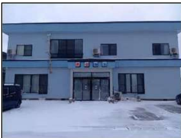
宿舎正面入口
