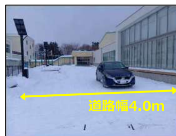
敷地内道路幅6m
