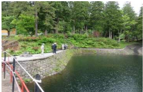
修復後の堰堤右岸
