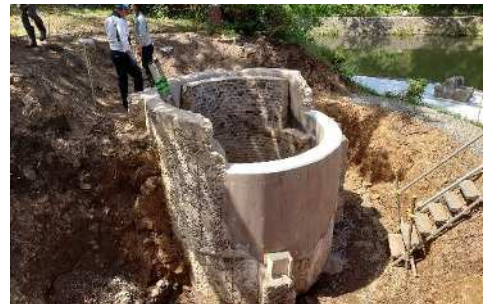
修復後の甲水槽
