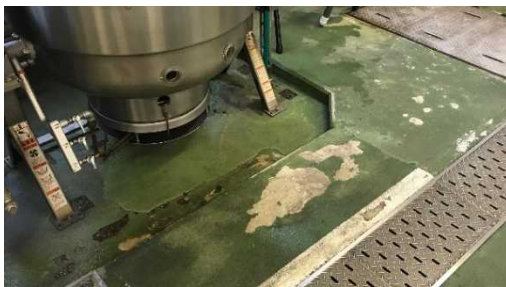
床塗装の剥がれ・屋根材の劣化・煙突の劣化 など
