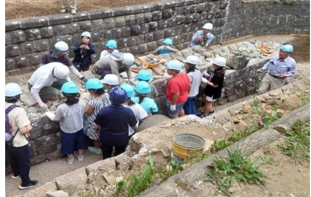
児童による工事現場での石積み体験
