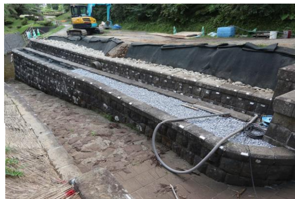
堰堤下流中央石積修理工事
