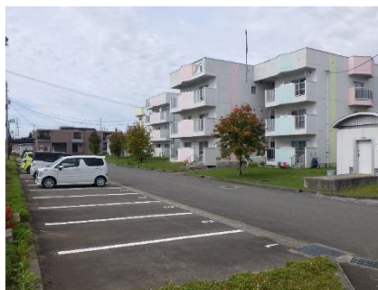
緑町団地（駐車場）
