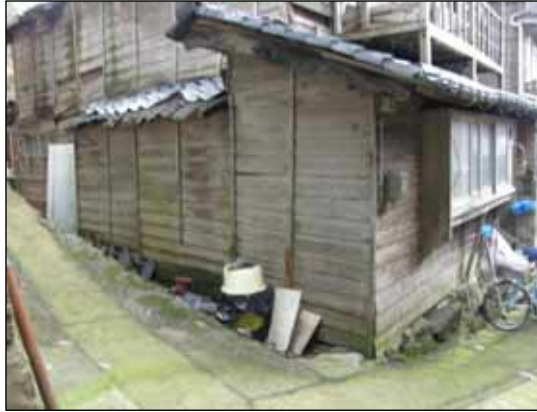
外壁が裸木造の例
