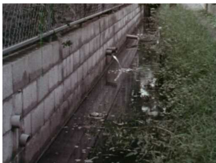
(下水道整備前)
