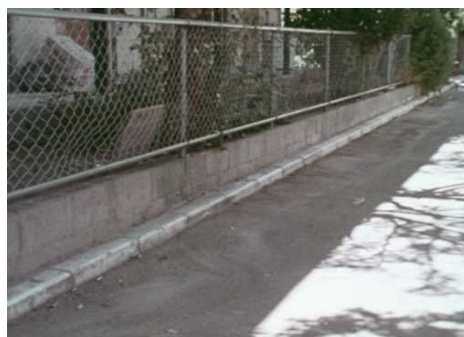
(下水道整備後)
