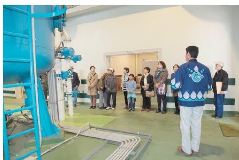
水道週間 水道施設見学会
