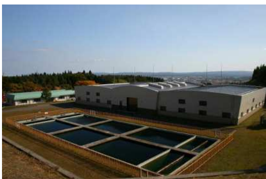
荒川浄水場ろ過池上屋
