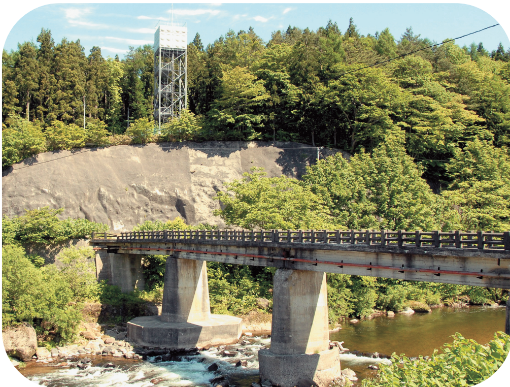
大畑小目名配水塔
