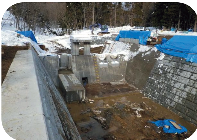
八木沢川取水口（建設中）
