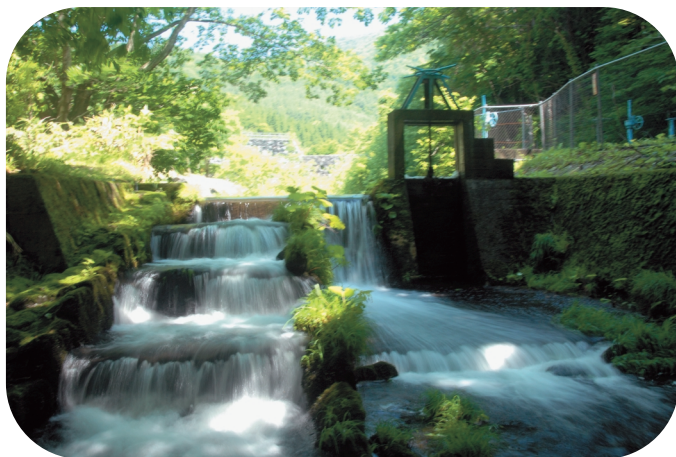
脇野沢川取水口
