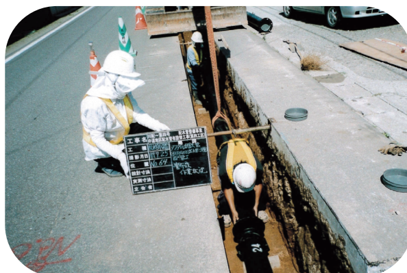
老朽管布設替工事
