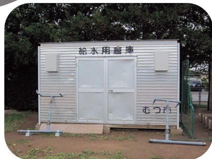
応急給水用資材庫（第二田名部小学校グラウンド内）
